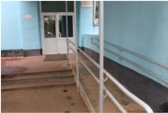
Пандус при входе в школу
